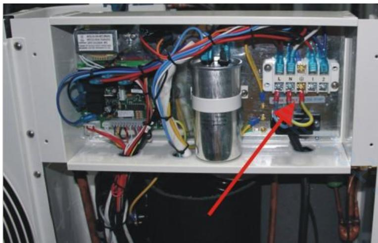
Note: Dans le cas des modèles triphasés, inverser deux phases pourrait entraîner que les moteurs électriques fonctionne dans le sens inverse, ce qui va entraîner des dommages. Pour cette raison, il y a une device protective équipée pour interrompre le circuit si la connexion n'est pas correcte.
