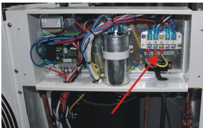
Anmerkung: Im Fall des Drei-Phasen-Modells, können zwei vertauschte Phasen dazu führen dass der Motor in die umgekehrte Richtung läuft, was zu einem Maschinenschaden führen kann. Aus diesem Grund hat das Gerät eine integrierte Schutzeinrichtung, die den Stromkreis unterbricht, wenn die Verbindung nicht korrekt ist. Wenn die rote LED-Lampe oberhalb dieser Sicherheitseinrichtung leuchtet, **müssen Sie die Anschlüsse von zwei der Phasenleiter vertauschen.**
