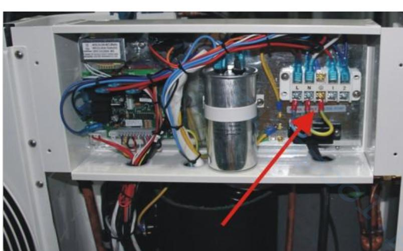
**Примечание:** В случае трехфазных моделей, замена двух фаз может привести к работе электродвигателей в обратном направлении, что может привести к повреждениям. По этой причине, устройство оснащено встроенным защитным устройством, которое размыкает цепь при неправильном соединении. Если загорается красный индикатор внизу предохранительного устройства, **Вы должны поменять местами подключение двух фазных проводов.**
