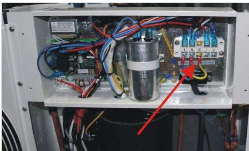
Opmerking: In het geval van 3-fase modellen, kan verwisseling van twee fases veroorzaken dat de elektrische motoren in de tegengestelde richting draaien, wat tot schade kan leiden. Om deze reden, heeft het apparaat een ingebouwde bescherming die het circuit verbreekt als de verbinding niet correct is. Als de rode LED boven dit veiligheidsapparaat oplicht, moet u de verbindingen van twee van de fasedraden verwisselen.
